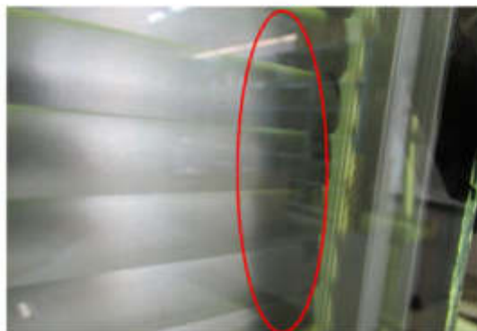
Bild 1: Abriebspuren auf den Lamellen
