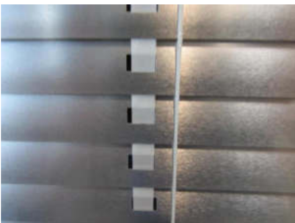
Bild 5 Zugband und Leiterkordel
